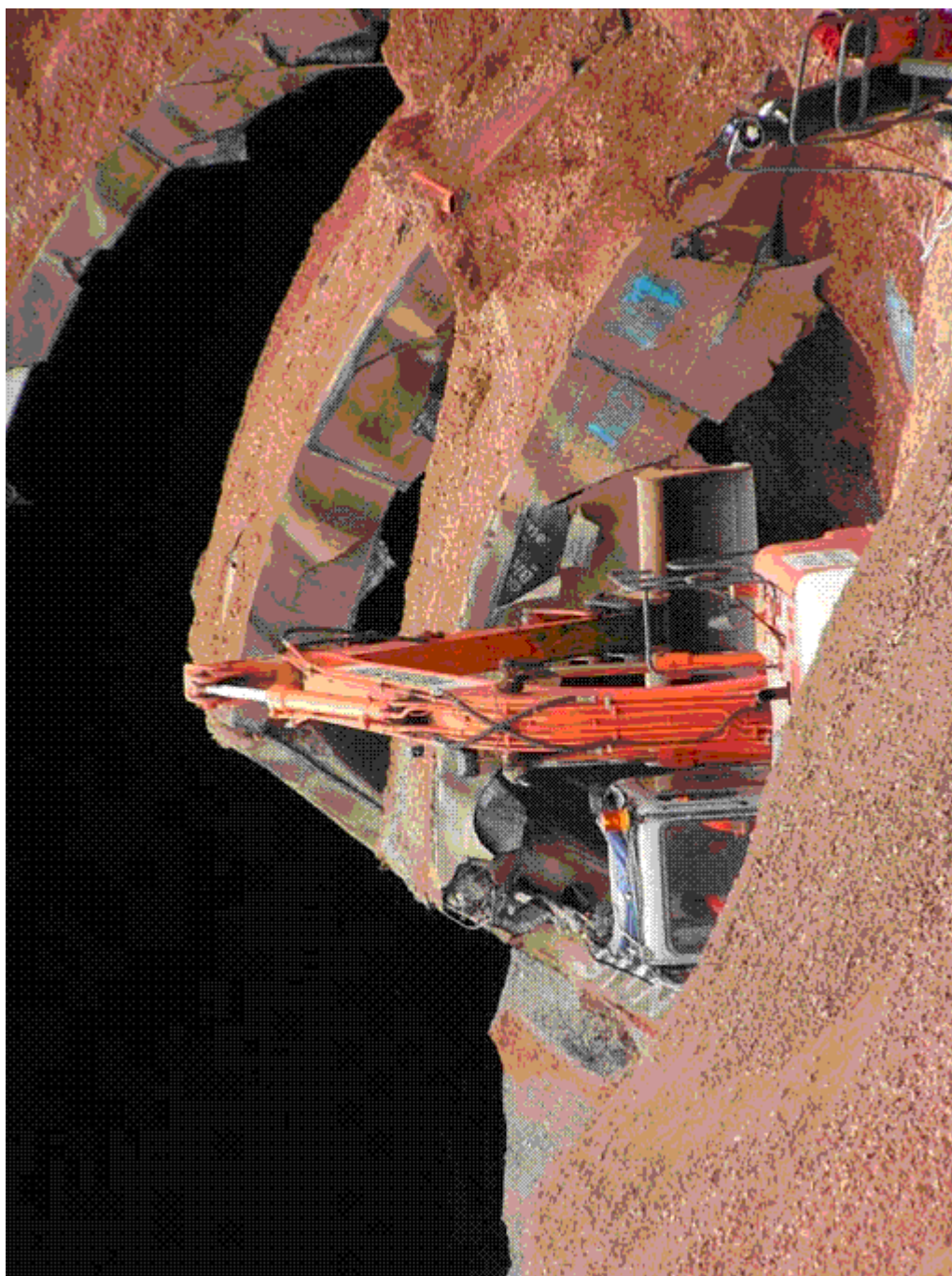
Figure 8.2c : "Tesco tunnel", après.
