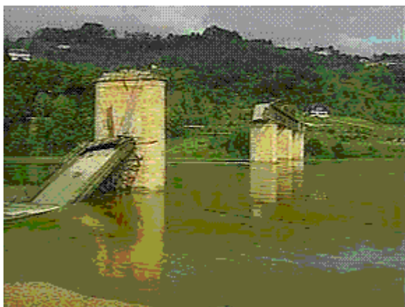
Figure 4.1a : Hintze Ribeiro, sur le Douro, Portugal, "Pont de fer", après.
