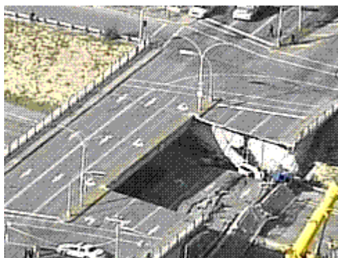
Figure 5.1 : Vue du pont effondré.
