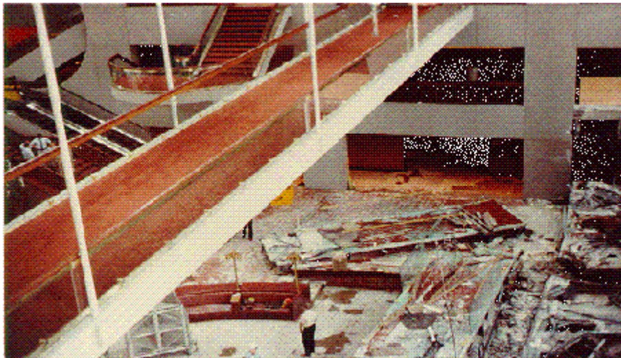
Figure 3.2a : Hyatt Regency Walkway, après.
