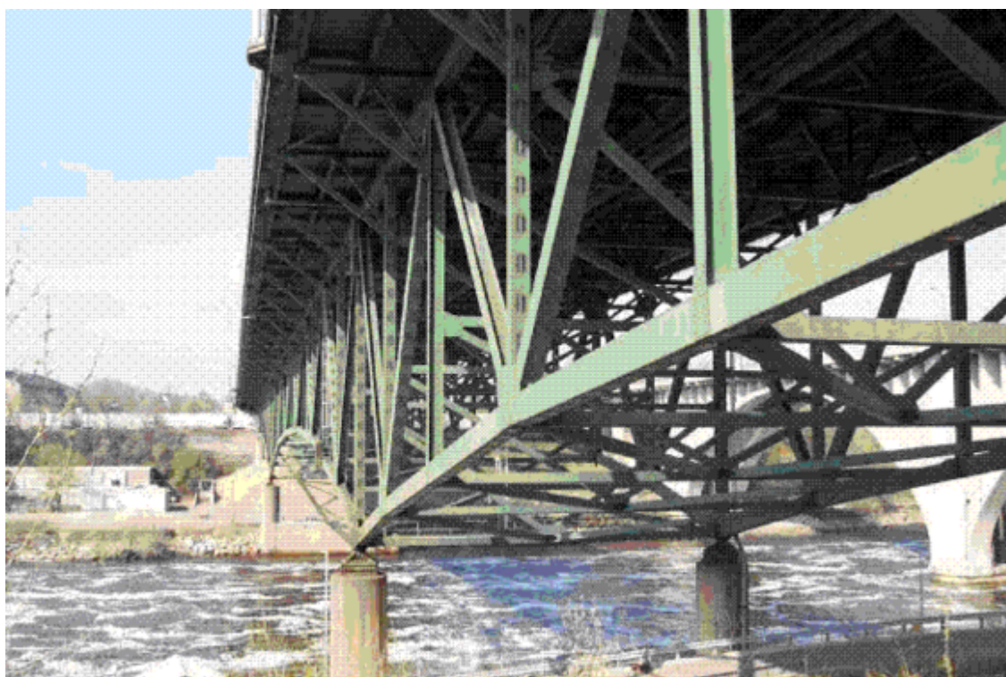
Figure 6.1 : Vue de la structure du pont.
