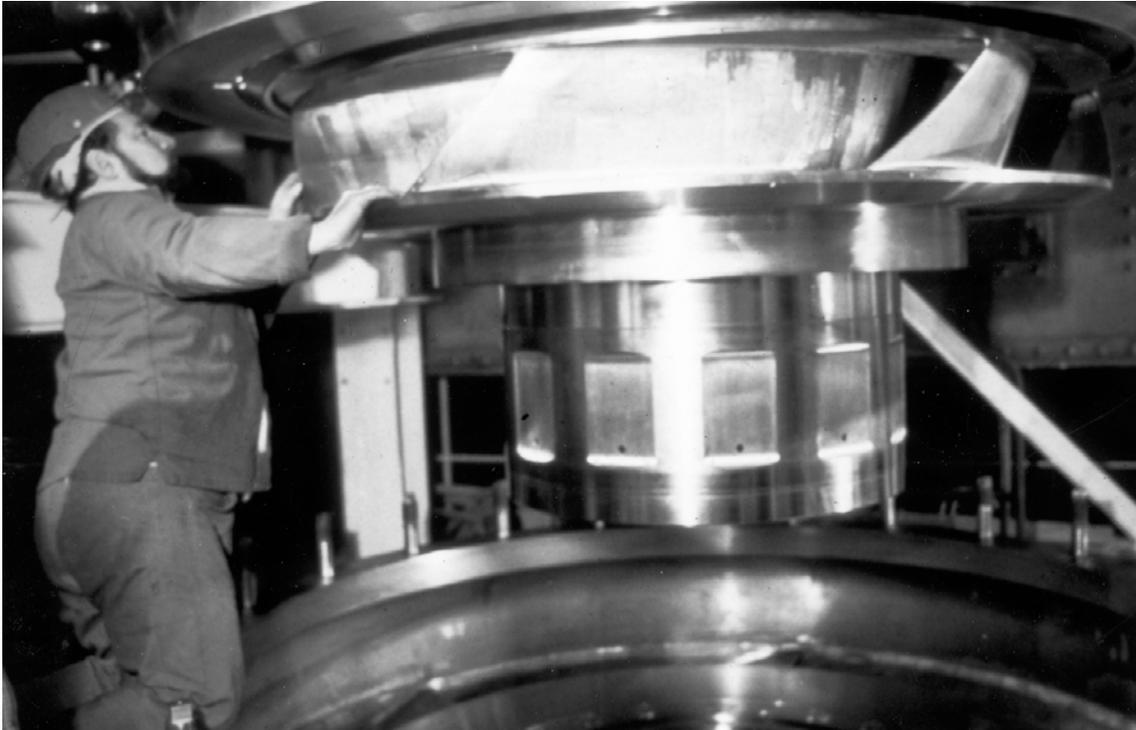
Fig. 22 : Paliers hydrostatiques de la pompe primaire de Super Phénix (DOCUMENT EDF)
